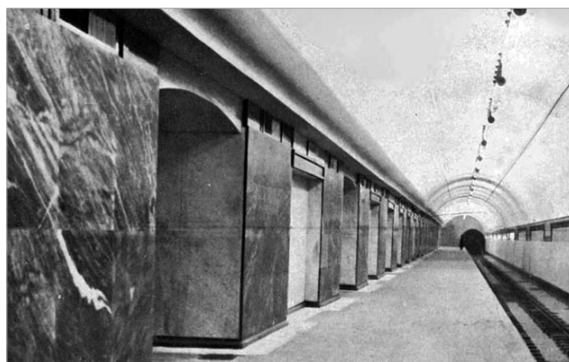
Платформа станции «Кировская» Московского метрополитена до оборудования там убежища
