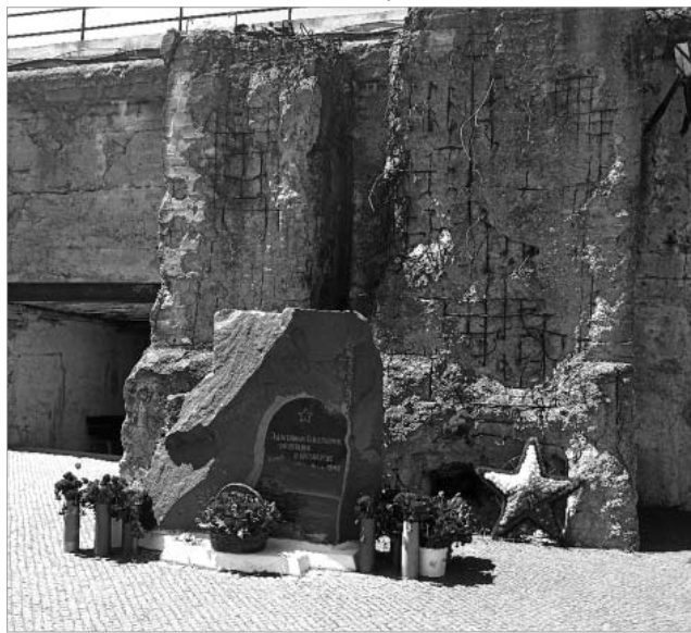
Вход в подземные казематы 35-й батареи
