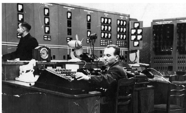
За пультом управления установки 400 кВ дежурный инженер Я.Борисанов, 1958 год.
